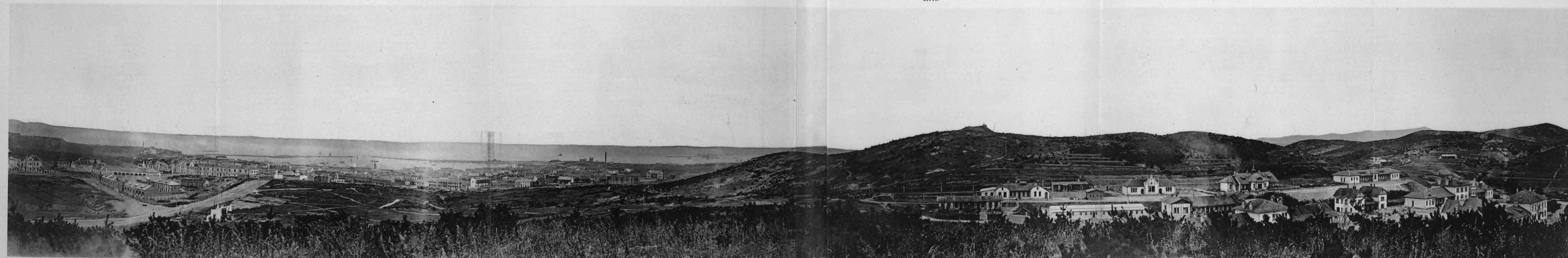
Geschäftshäuser. Elektrizitätswerk u. Oster's Fabrik. Katholische Mission. (Mädchenschule.) Kleiner Hafen. Mietshäuser von Suthlage & Siemens. Stadtteil Ta pau tau. Ziegelei. Großer Hafen. Wasserpumpe. Gouvernementslazarett.
